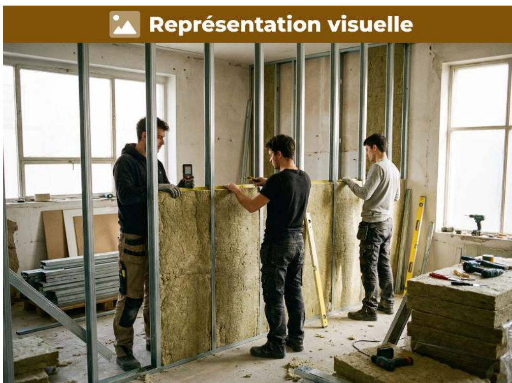
Installation d'un isolant de 45 mm dans une cloison pour optimiser la performance thermique
