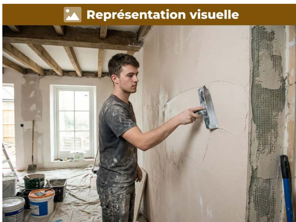
Application d'un enduit sur un mur avec un temps de séchage de 48 heures entre chaque couche
