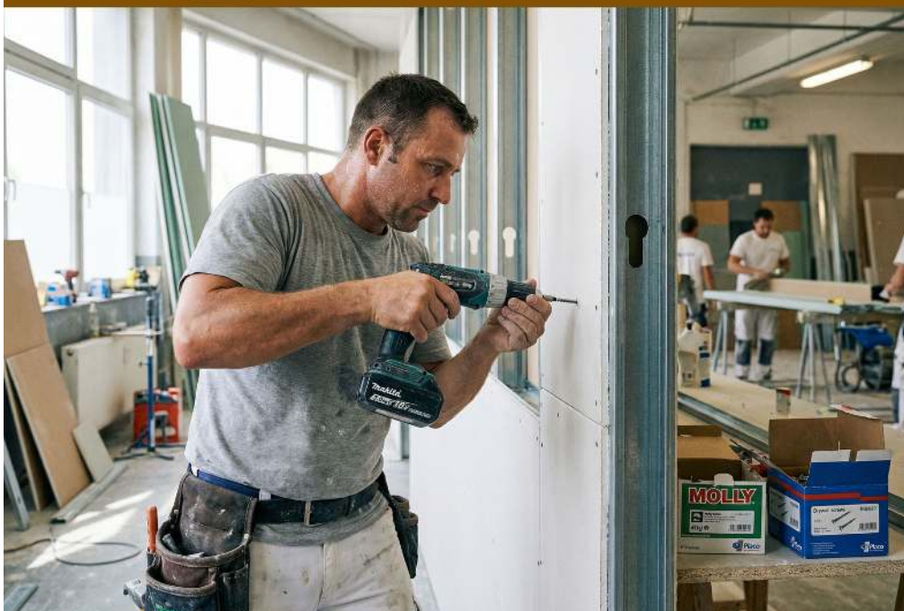
Fixation de plaques de plâtre sur ossature métallique avec entraxe de 600 mm
