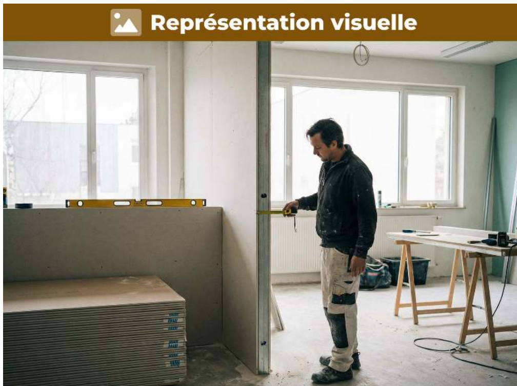
Mesurer l'épaisseur d'une cloison en placo pour garantir conformité des normes de construction
