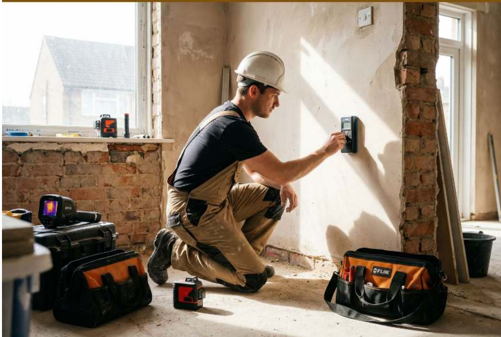
Mesure de l'humidité du support pour garantir une bonne adhérence des matériaux
