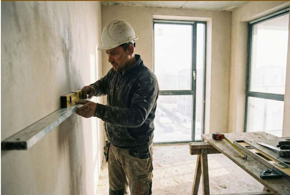
Contrôle de la planéité d'un mur avec une tolérance de 2 à 3 mm sur 2 m
